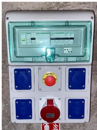
Coffret électrique mural mis à disposition à la Galerie David d'Angers (Adaptateur hypra 32A + 10m de rallonge à prévoir)
